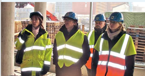
Kristina Törnblom (t.v.) från Strängbetong, tillsammans med tre imponerade besökare efter luftfärden till 18:e våningen i höghuset i kv. Lusten.
