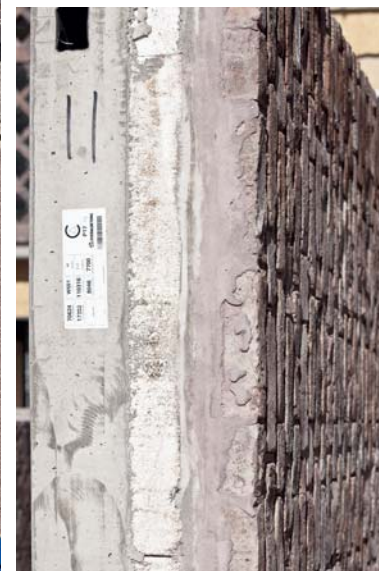
Till vänster ses Pagodens fasad med monterade rasterfönster. Uppre till höger syns det gamla rustika teglet och under detta det 7 ton tunga betongelement som Strängbetong monterat teglet på.
