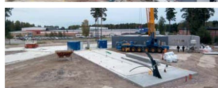
Tack vare en smart byggteknik tog det inte mer än 1 år och två veckor från byggstart tills att Connect Hotel i Skavsta stod färdigt.
