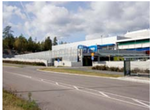
Kvarteret Tygeln Adress: Gårdsvägen Ort: Solna Arkitektkontor: WSP Byggherre: NCC Byggår: 2001 Yttervägg: Beklädnadselement Fasadtyta: Ingjutet tegel
